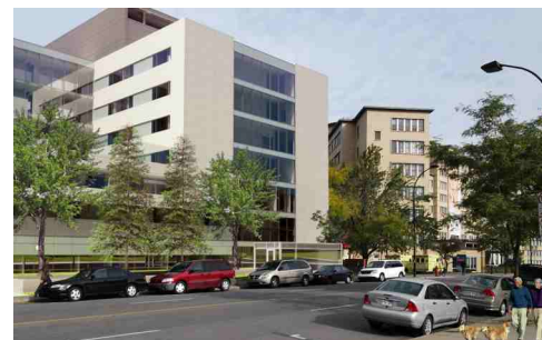
Vue du bâtiment des unités spécialisées (BUS), depuis le chemin de la Côte-Sainte-Catherine
